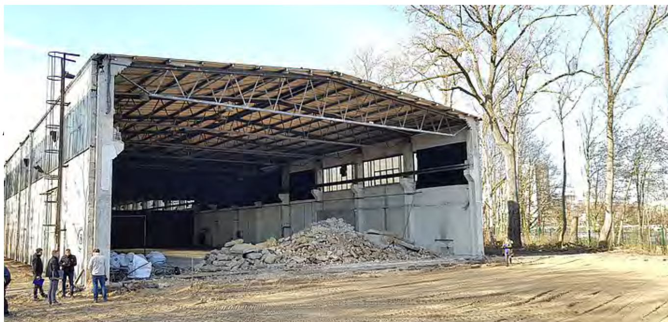
Abb. 5.30 Teilrückbau der Werkhalle (© Grün Berlin)
