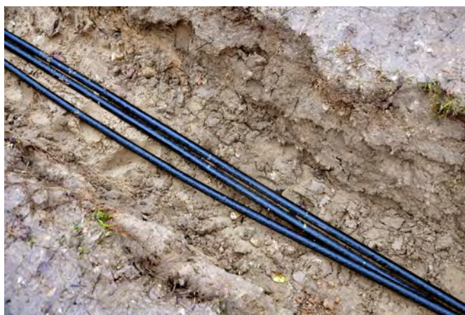
Abb. 5.18 Kabelverlegung Photo: Adobe Stock | struvictory
